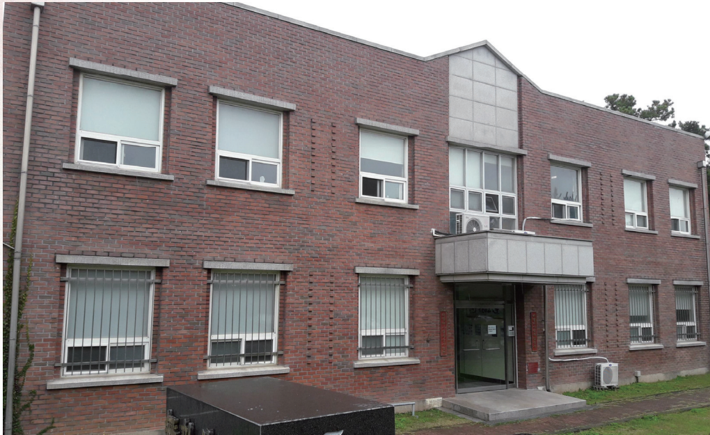
[해병사 군사법원 청사 전면]
