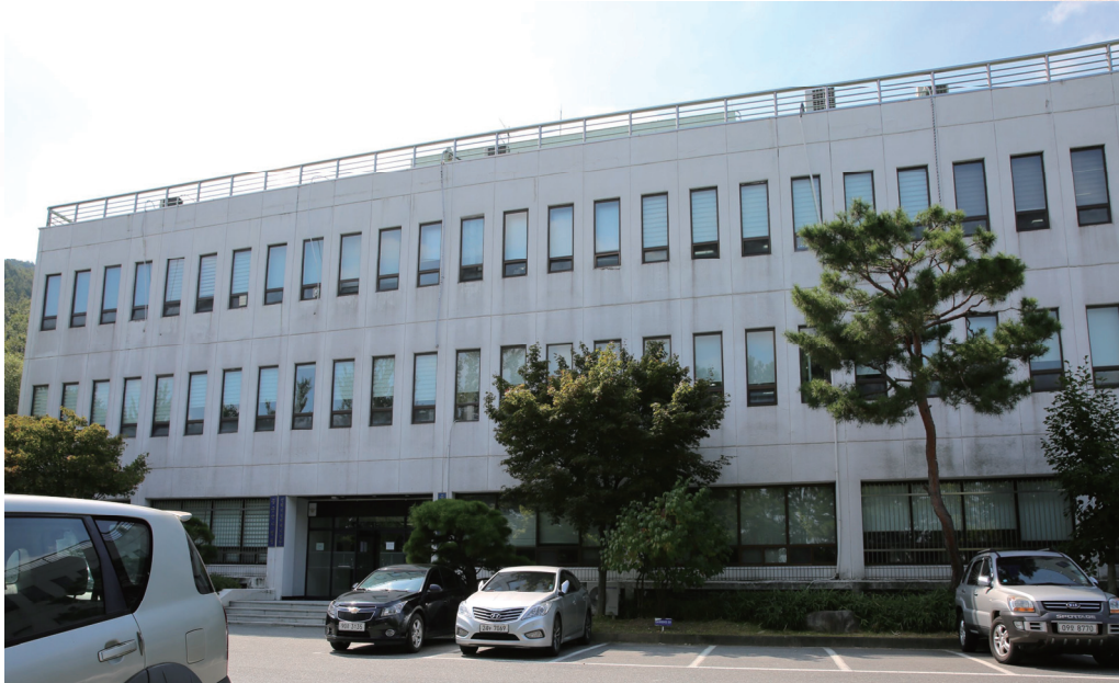
[공군본부 군사법원 청사 전면]
